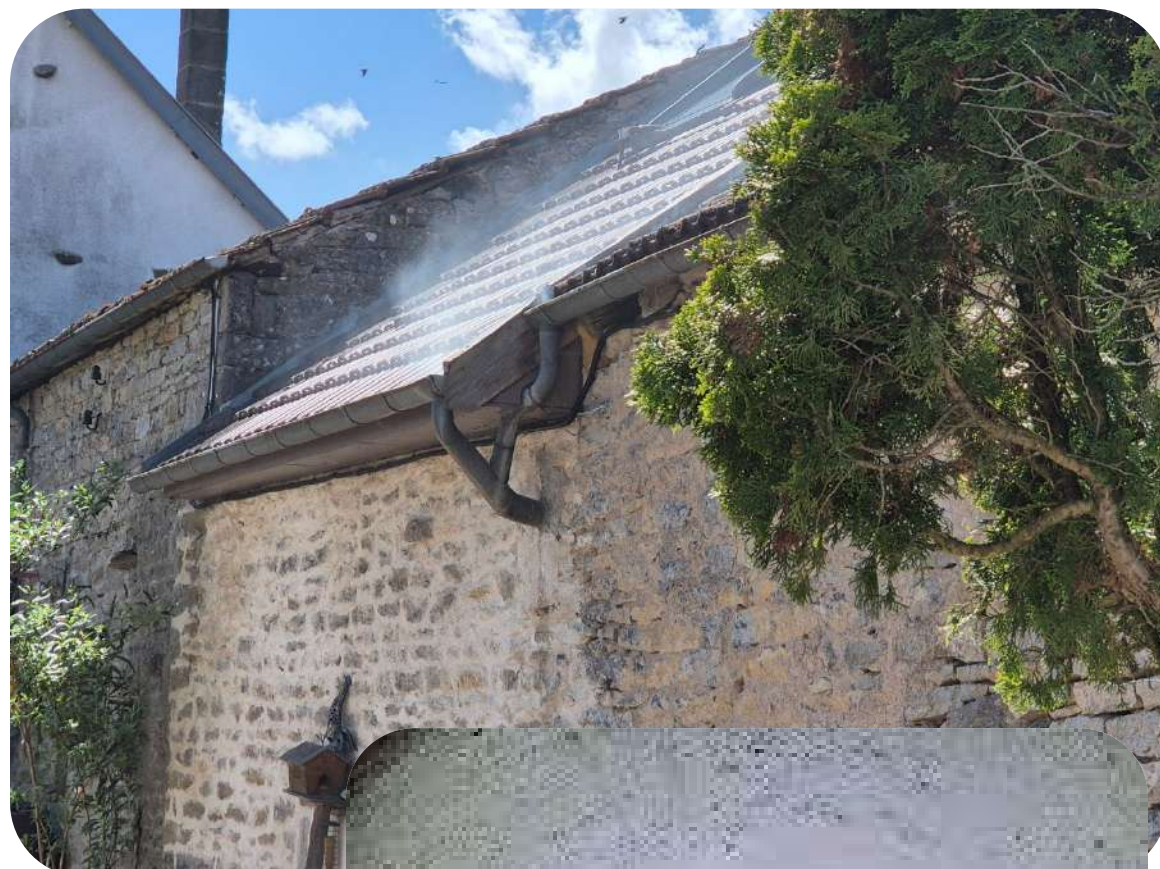
Test à la fumée (Contrôle des branchements)
